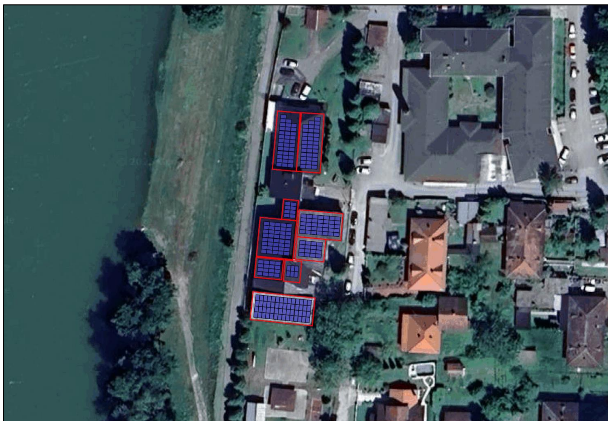
Sl. 3-36 Raspored fotonaponskih panela, Predškolska ustanova „Crvenkapa“, Mali Zvornik (Izvor: Base K2)
