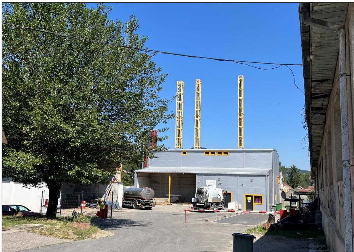
Sl. 3-18 Toplana na biomasu, Mali Zvornik
