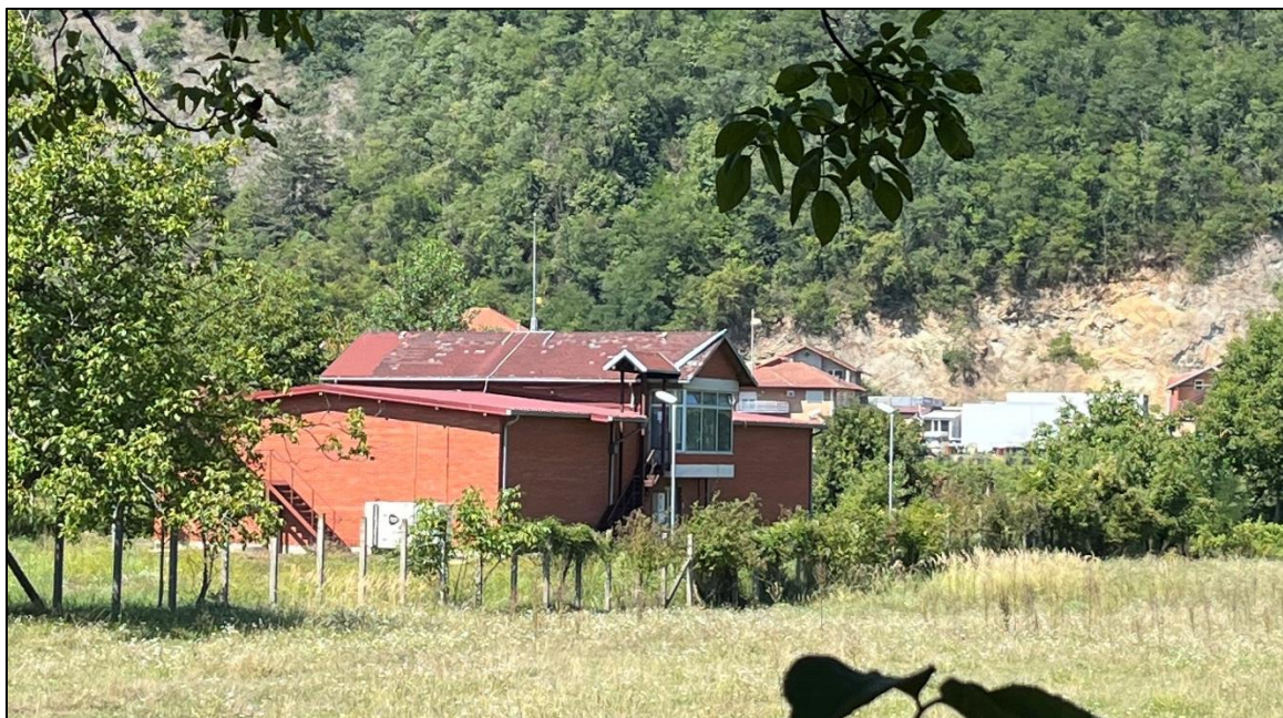
Sl. 3-26 Crpilište vode „Šipad“ (2)
