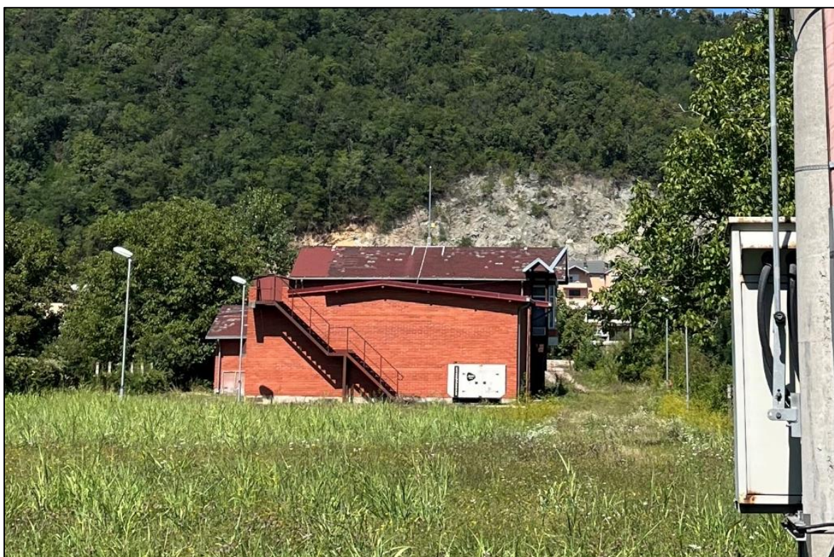
Sl. 3-25 Crpilište vode „Šipad“ (1)
